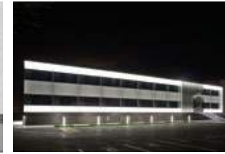
Riqualificazione direzionale Mirage Mirage Office Building Renovation Pavullo, MO (I) – p. 88
