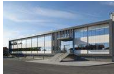
57 Riqualificazione direzionale Mirage, Pavullo (I)
