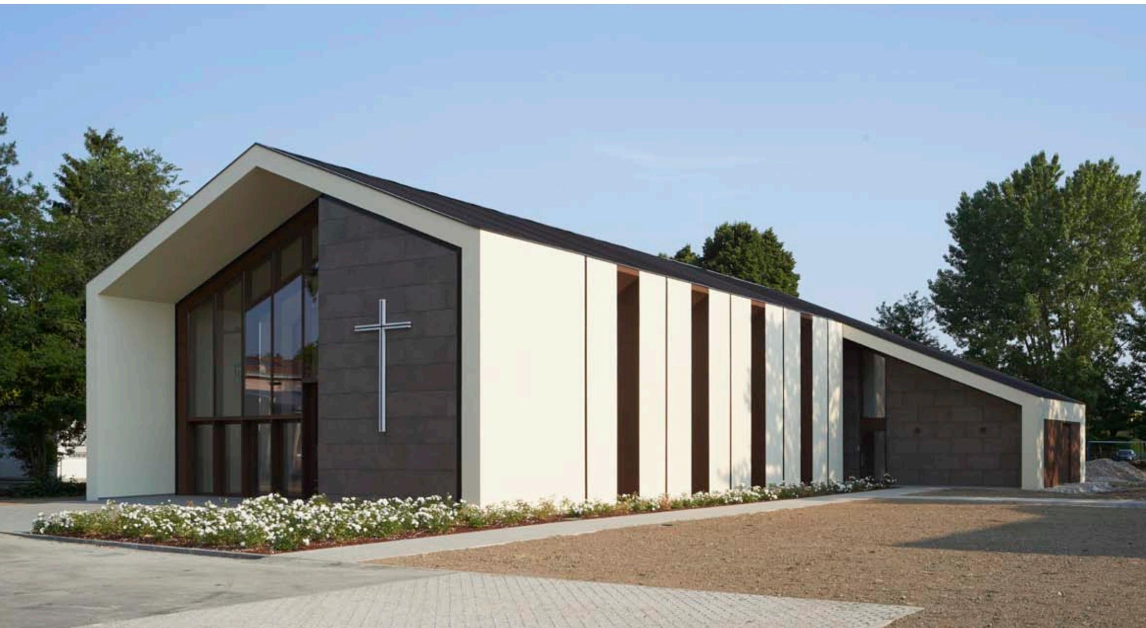
L'esigenza di coniugare rapidità esecutiva, sicurezza sismica, eco-sostenibilità e contenimento dei costi di gestione, orientò sin da subito la scelta sulla tecnologia della prefabbricazione in legno.
